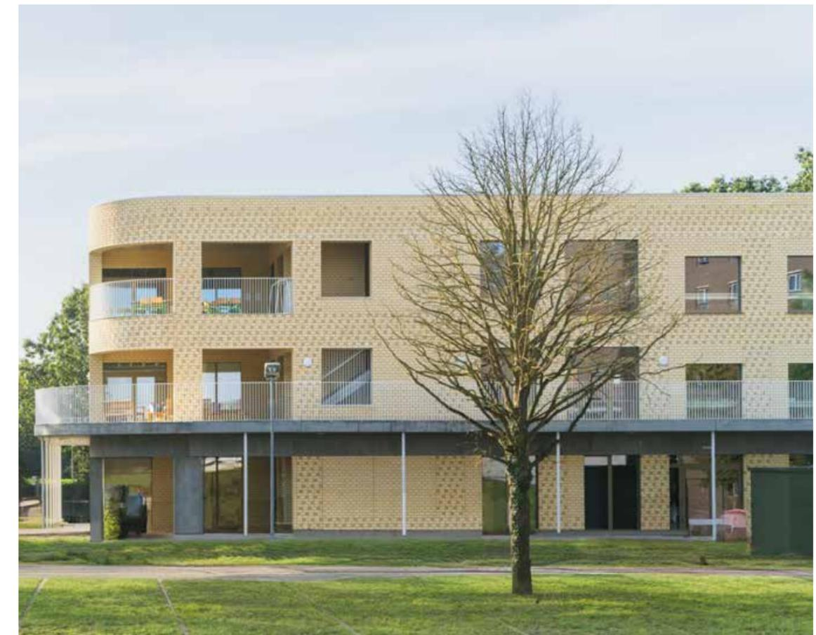
Le motif spécifique de la façade est constitué en partie d'un appareillage en quinconce à demi-brique et en partie d'un appareillage en carrelage, en alternance avec des boutisses.
