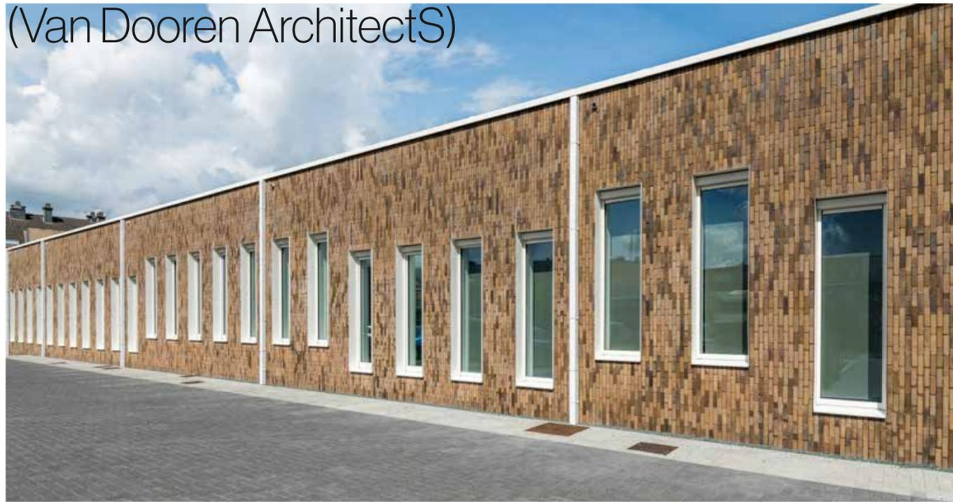
La mise en œuvre à la verticale, à l'horizontale et en diagonale des briques de parement donne à la façade un aspect intrigant.
