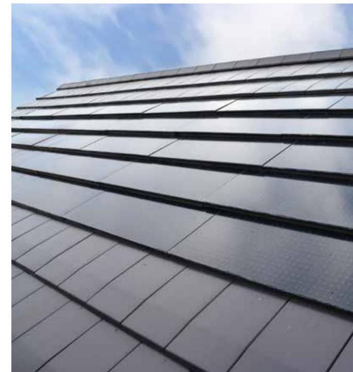
Les panneaux X-Tile s'intègrent parfaitement dans les toitures couvertes de tuiles en terre cuite Koramic Actua 10.
