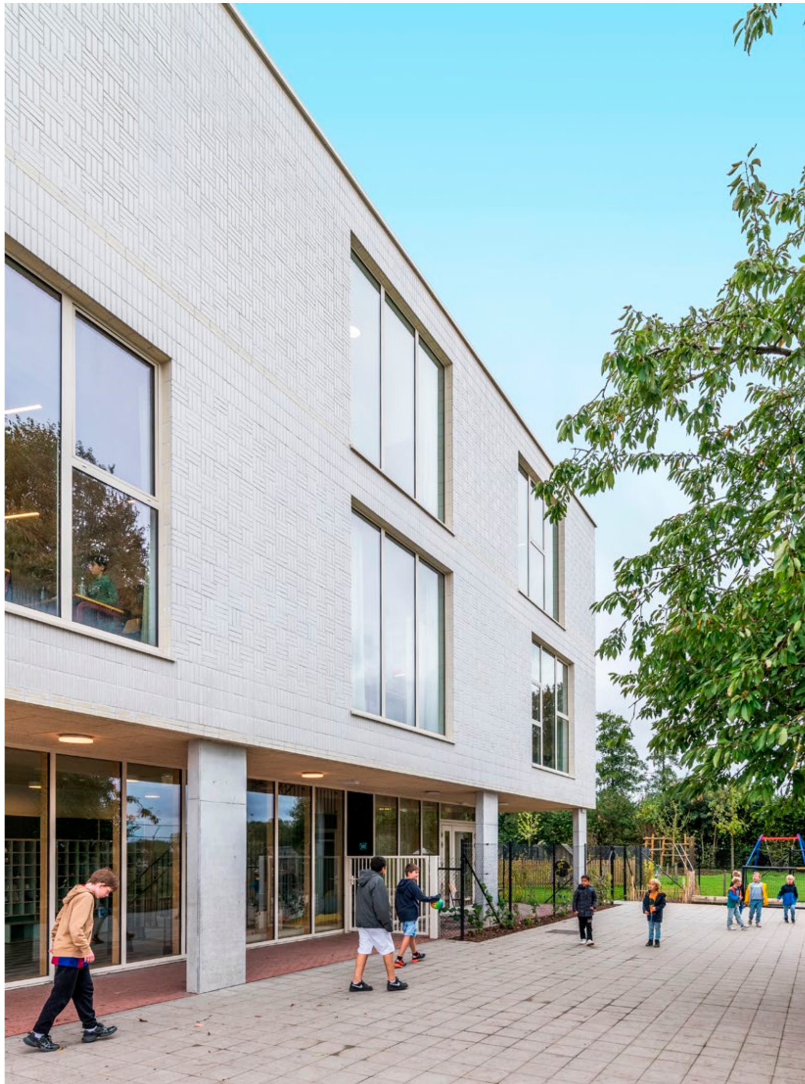
Pour l'école primaire communale De Spingplank, les cabinets d'architecture ZAmponé & Ark ont conçu une architecture moderne en brique accordant un rôle central au jeu des motifs.
