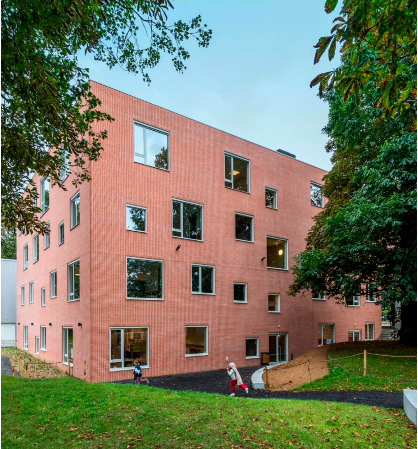
L'application d'un faux joint crée une superposition en apparence simple de briques carrées dans la façade. Concept : Oskar architecten, Dilbeek
