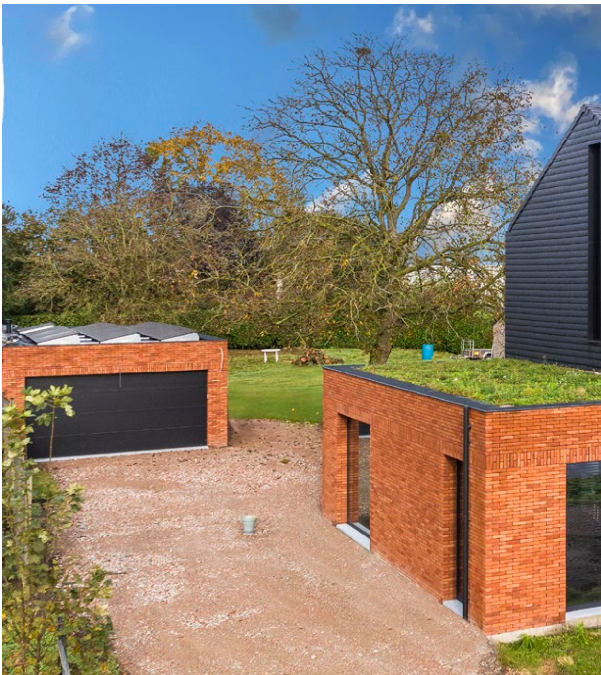
Gevel: Terca Amfora Rubino / Dak: Koramic Elfino Antraciet mat
