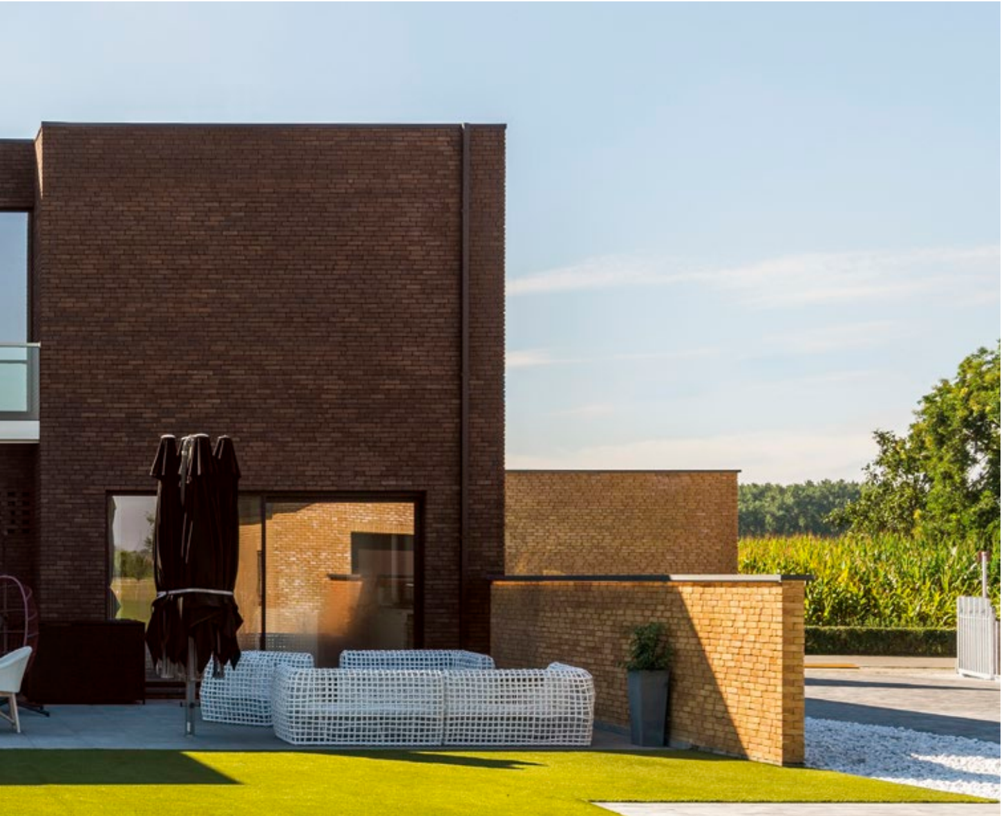
Architectenbureau Tyberghien & Partners, Gent
