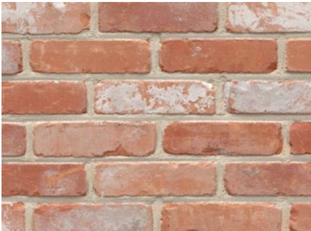
Recup Tongerse Rijnvorm RV ± 178x83x48 mm
